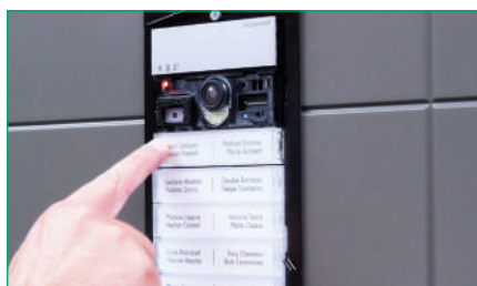
10. DRUK op de drukknop waaraan het geselecteerde adres van de vorige stap wordt toegekend. De correcte toekenning van het adres wordt gesignaleerd door een bevestigingstoon. SELECTEER achtereenvolgens de andere drukknoppen. Deze krijgen automatisch het oproepadres met de volgende code
