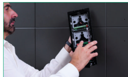
4. MONTEER het deurstation op de wand, voer de voedingskabels door de betreffende opening en zet ze vast met de twee schroeven, boven en onder
