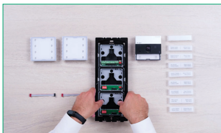
2. RETIRER le cadre et positionner les modules à l'aide du système d'accrochage rapide
