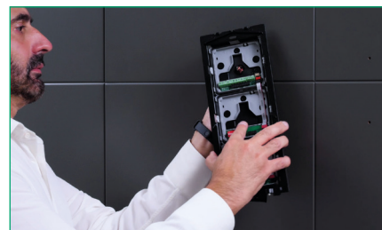
4. POSITIONNER la platine murale, faire passer les fils de l'alimentation dans le boîtier et le fixer à l'aide des deux vis situées en haut et en bas
